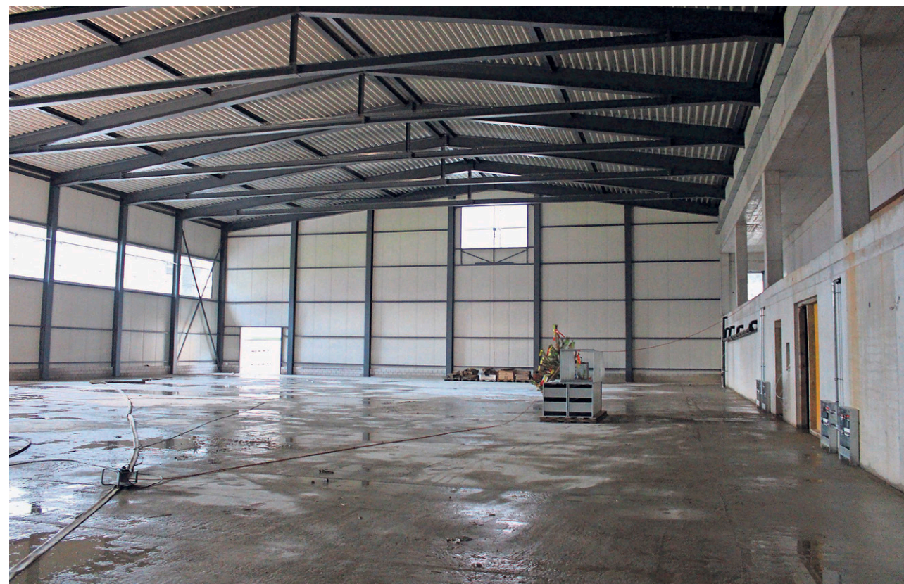
Die Halle ist mit ihrer Höhe sowohl für Floorball- als auch Handball-Wettkämpfe geeignet. Rechts werden noch zwei Tribünenteile angebaut.
