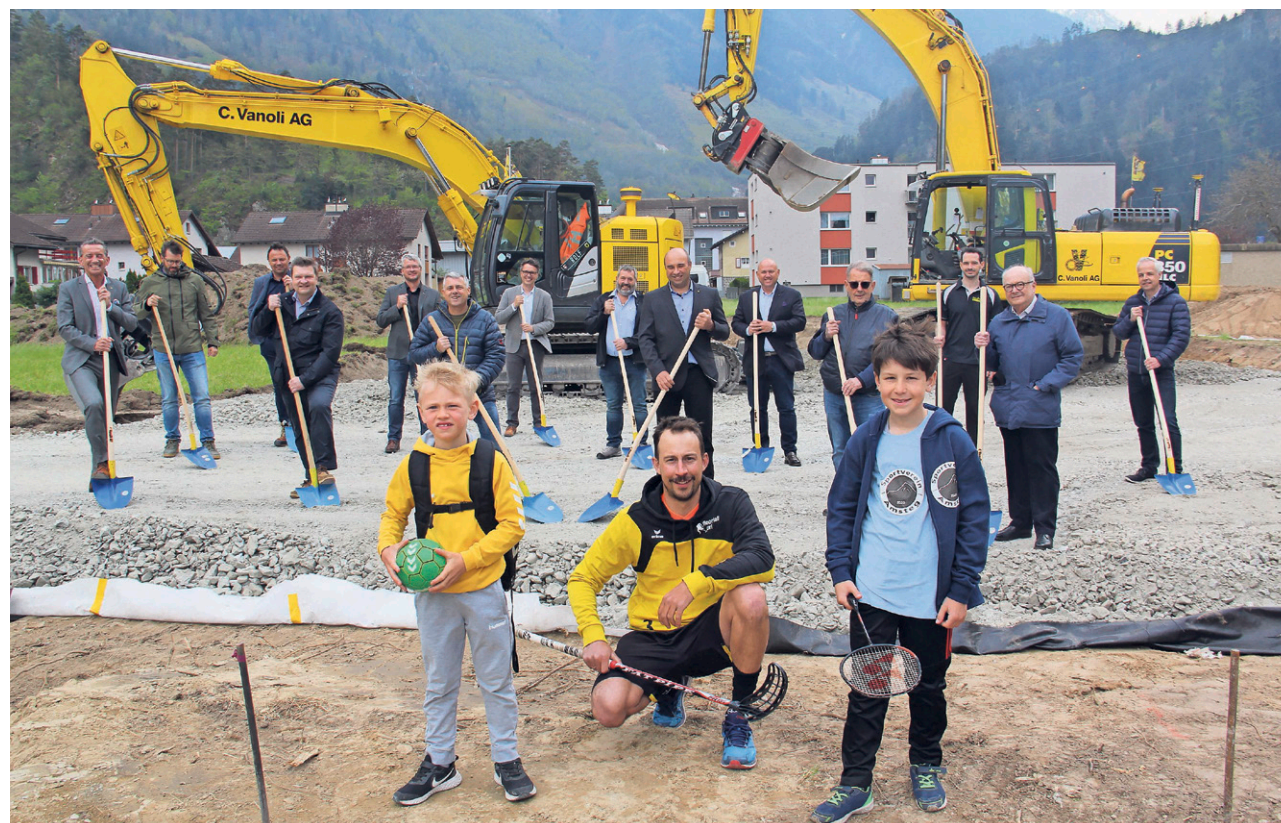
Am Spatenstich waren unter anderem Vertreter der Vereine dabei, welche die Dreifachturnhalle künftig nutzen wollen: (vorne, von links): Dario Brand (Handballklub), Rolf Arnold (Floorball Uri) und Andreas Gerig (Sportverein Amsteg).
